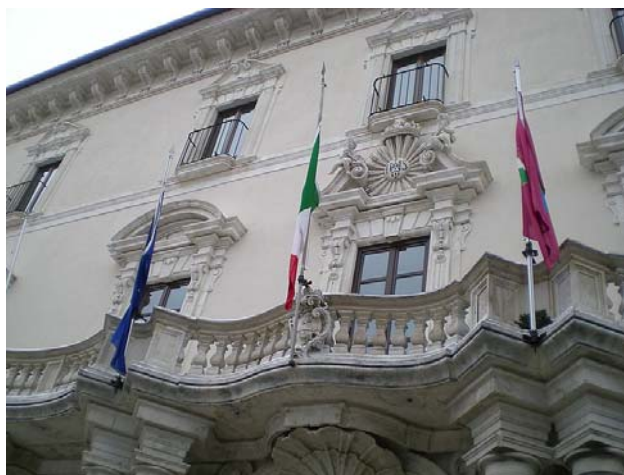
Palazzo Centi, particolare della balconata Foto tratta da it.wikipedia.org
