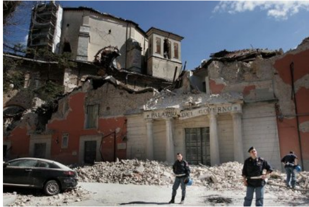
Palazzo della Prefettura (già Convento degli Agostiniani), dopo il sisma
