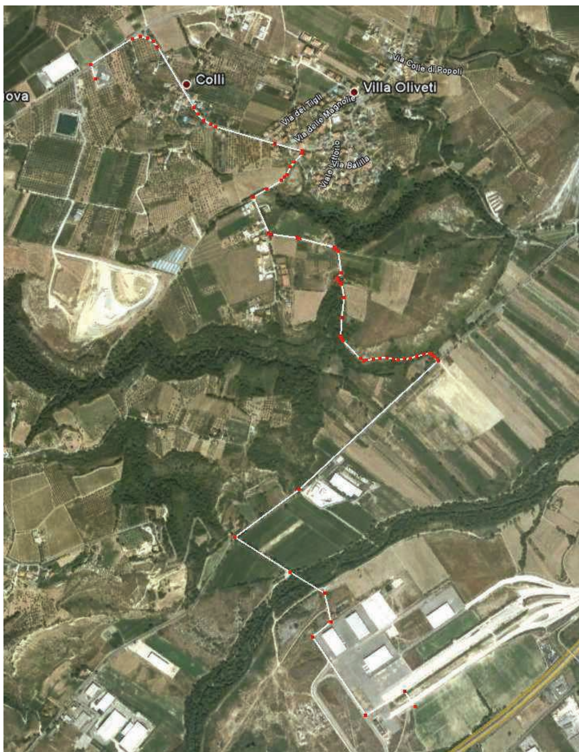
Vista aerea elettrodotto
