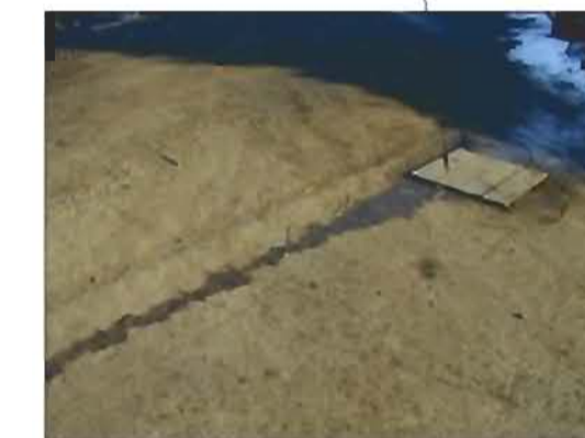
Pozzetto di raccolta delle acque del piazzale in cui avvengono le lavorazioni
