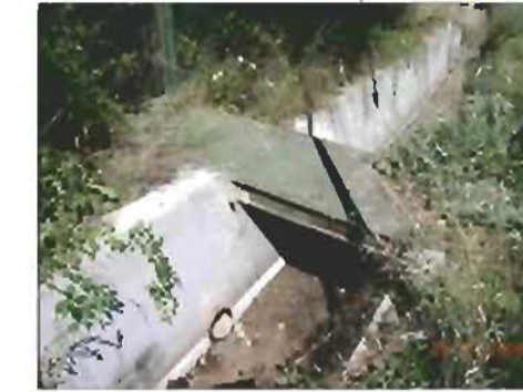
Pozzetto di raccolta delle acque del piazzale in cui avvengono le lavorazioni
