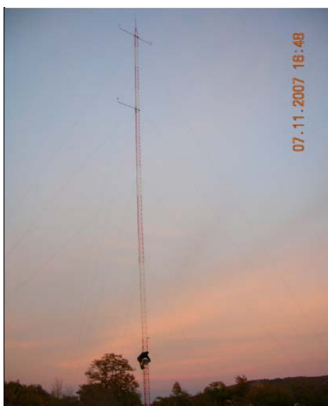
Figura 7: Vista da Nord-Est della torre anemometrica installata a Colle Pistilli
