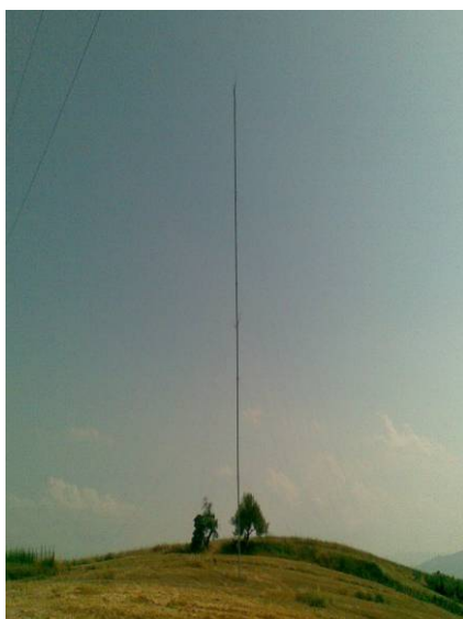
Figura 7: Vista da Nord-Est della torre anemometrica installata a Contrada Ramignano
