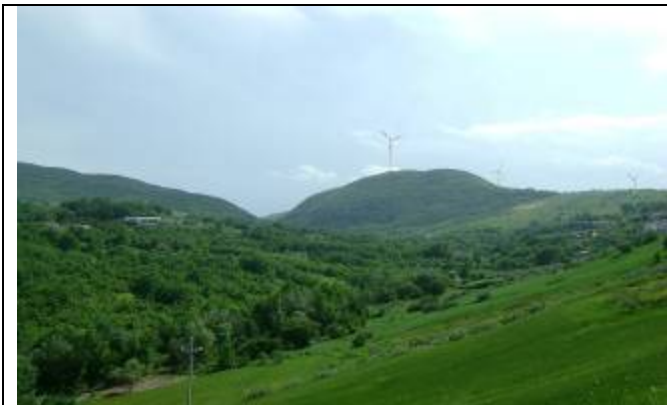
Vista di T06, T09 e T10 da NE
