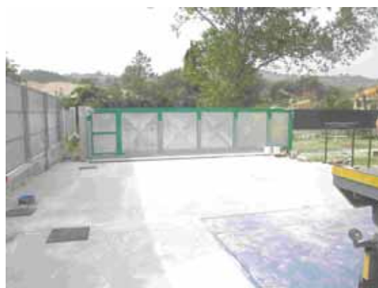
FOTO 2 – CANCELLO DI INGRESSO
