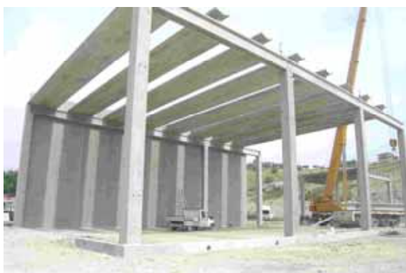
FOTO 1 – CAPANNONE IN COSTRUZIONE, LATO SUD-EST
