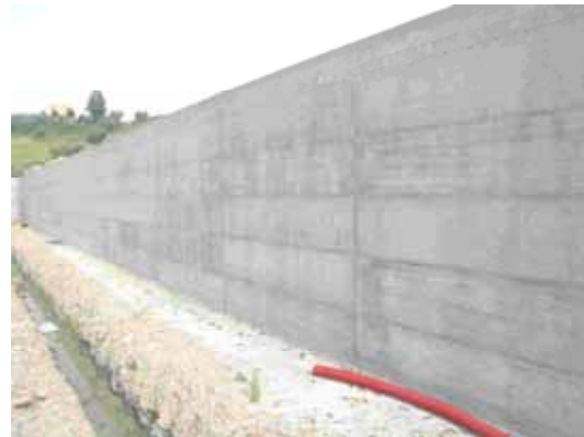
FOTO 6 – MURO DI CONTENIMENTO
