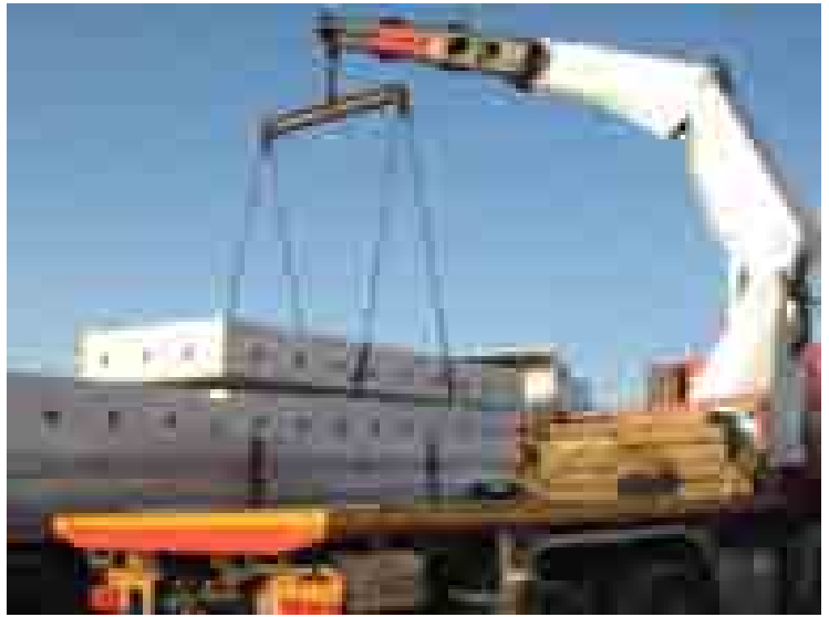
Figura 3 Esempio posa in opera cabina
