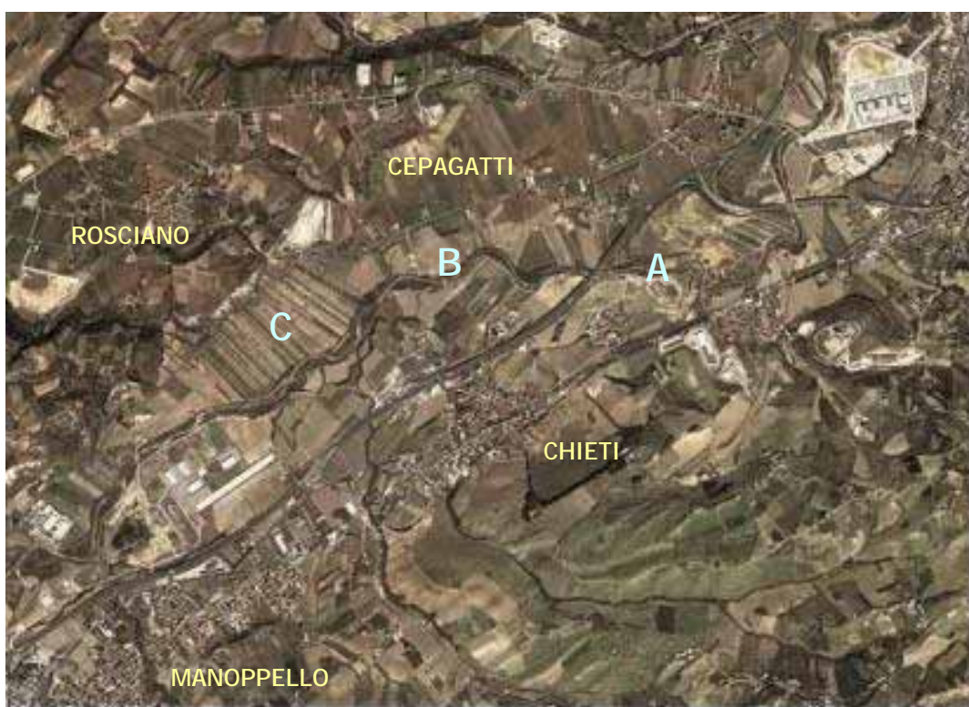
Figura 1.2 - Ortofoto dell'area interessata dalla realizzazione dei bacini di laminazione (A, B e C).
